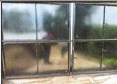
Foto 5: MANTENIMIENTO A PORTON: Cambio de lamina, pintura, techo.
