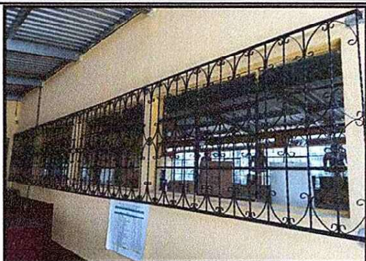
Foto1: . VENTANAS: Colocación de balcon y vidrios.
