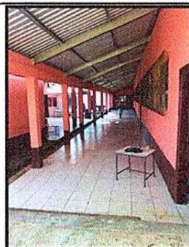
Foto 4: PINTURAS EN MUROS INTERIOR Y EXTERIOR
