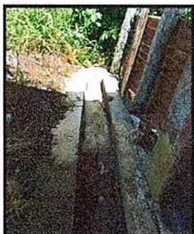
Foto 3: CUNETAS DE CONCRETO.
