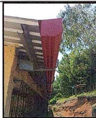
Foto 2: CANALES Y BAJADAS DE AGUA PLUVIAL
